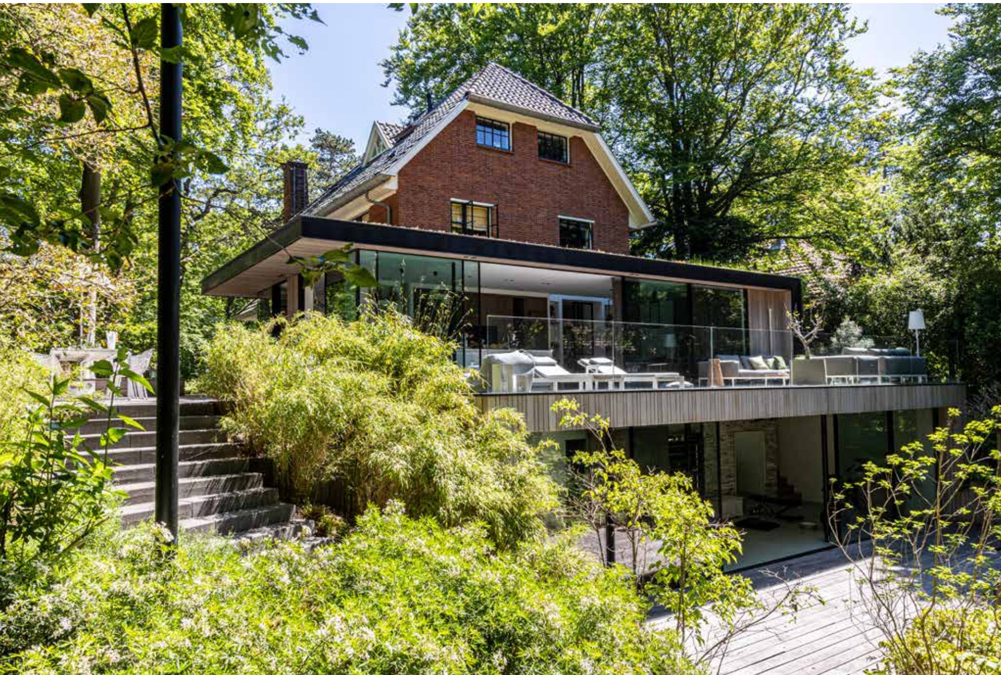
Het achteraanzicht met de eigentijdse aanbouw, de aangrenzende buitenterrassen en de verborgen woonlaag met een wellness en sportruimte.
